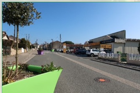
Rue de la Poste, travaux effectués en 2007.
