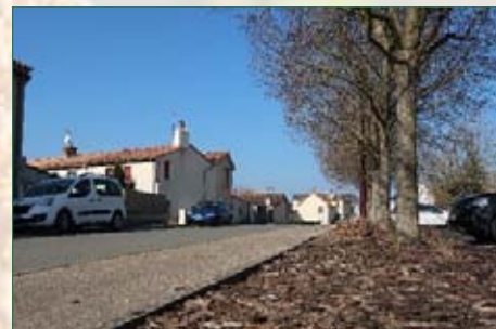
Rue du Bocage, travaux d'aménagement de la voie, d'enfouissement de réseaux, travaux paysagers (paillage avec des copeaux de bois résultant de l'élagage des haies effectué par les agents des services techniques).
