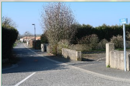
L'impasse de la Chapelle à La Laimière a été refaite avec enfouissement de réseaux et de nouveaux lampadaires à économie d'énergie (2016).
